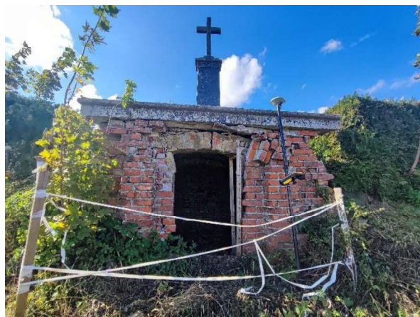
10 nuotr. Plyšiai besideformuojančioje kriptoje Š R kapinių dalyje (įgilinta viršutinėje šlaito briaunoje)
