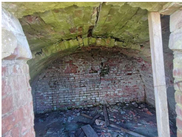
10 nuotr. Plyšiai besideformuojančioje kriptoje Š R kapinių dalyje (įgilinta viršutinėje šlaito briaunoje)
